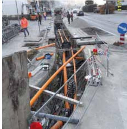
und zu entsorgen. Im Bereich des neuen Gehsteiges werden zudem noch die Versorgungsleitungen der Telekom, der TIWAG und die Straßenbeleuchtung untergebracht.
