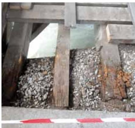
erte aber nicht lange, bis man feststellen musste, dass ein Teil der Unterkonstruktion aufgrund von Fäulnisbefall ein Befestigen der Bretter nicht mehr zuließ. Das hatte zur Folge, dass die Unterkonstruktion auf beiden Seiten der Brücke komplett ausgetauscht werden musste. Die Erneuerung der Brücke über den Seebach in Habichen war hingegen wieder keine Überraschung. Die erforderlichen Maßnahmen wurden ebenfalls durch die Gemeindefraktion durchgeführt.
